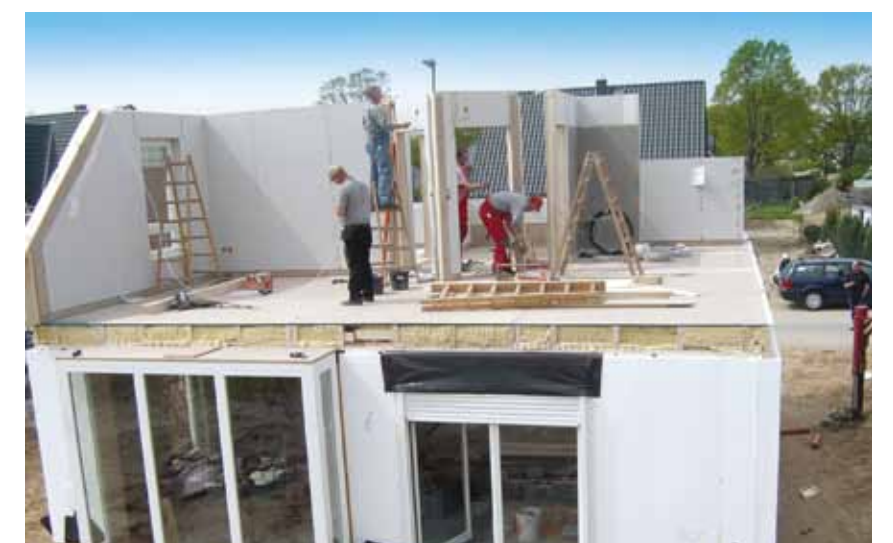
Endspurt: Nun geht es Schlag auf Schlag. Bald können die Bauherren hier mitanpacken und den Innenausbau selbst in Angriff nehmen.
