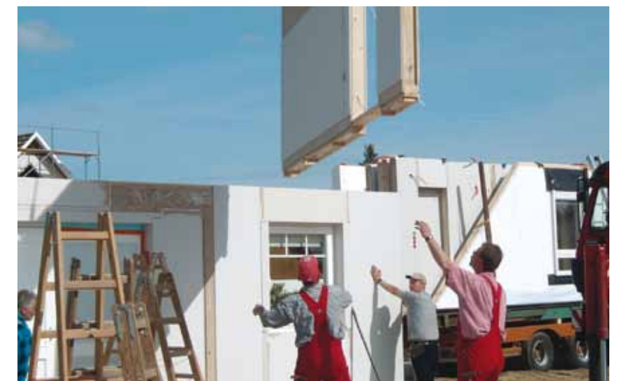
Schnell und zuverlässig: Dank der perfekt aufeinander abgestimmten Bauteile verläuft die Montage durch das ProHaus-Team vor Ort reibungslos.
